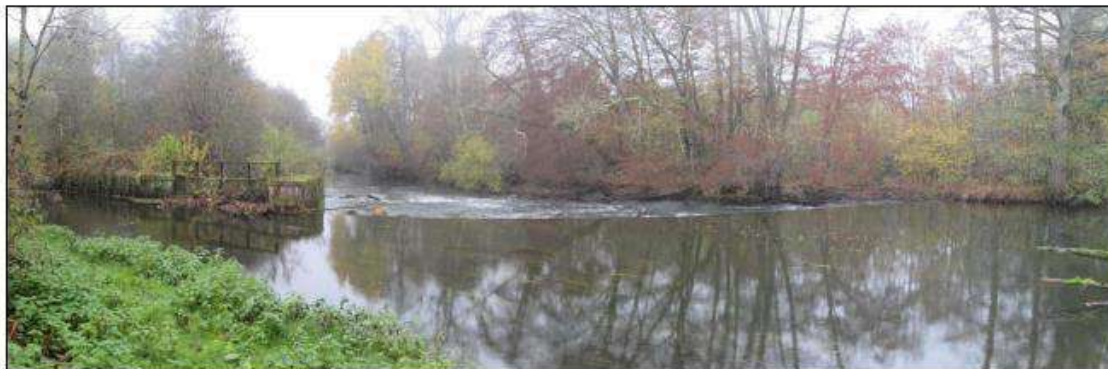
Photo n°1 : Vue amont du barrage
