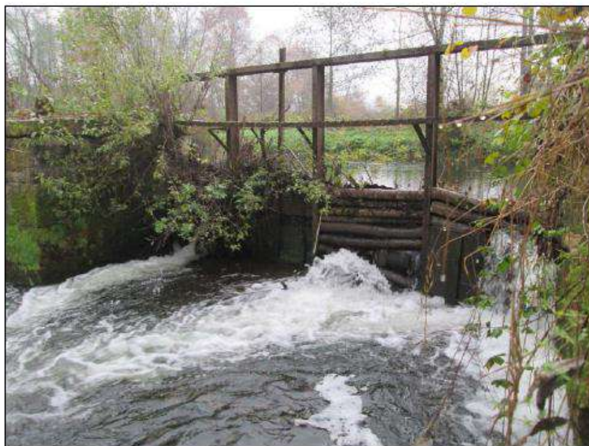
Photo n°4 : Vue aval du vannage de décharge
