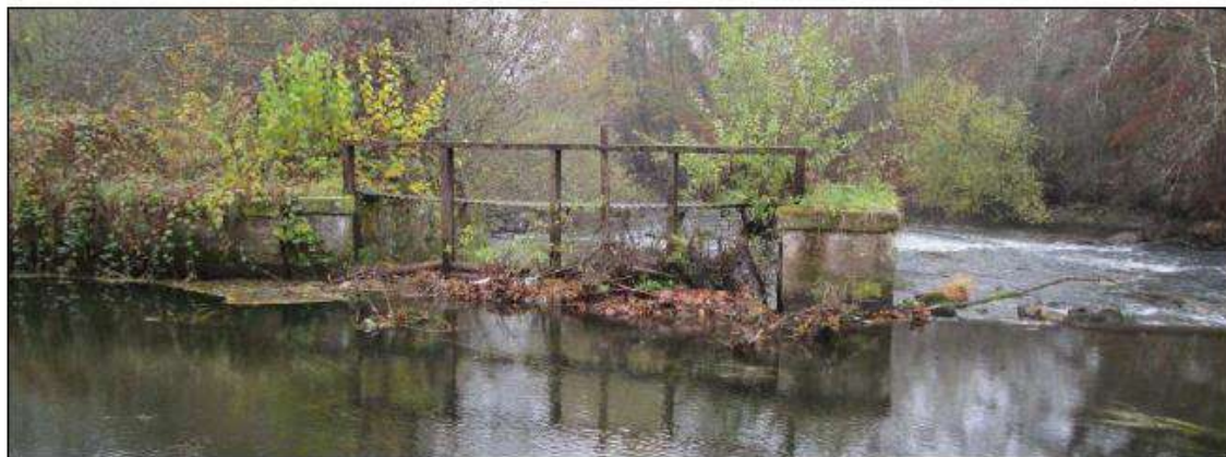
Photo n°3 : Vue amont du vannage de décharge
