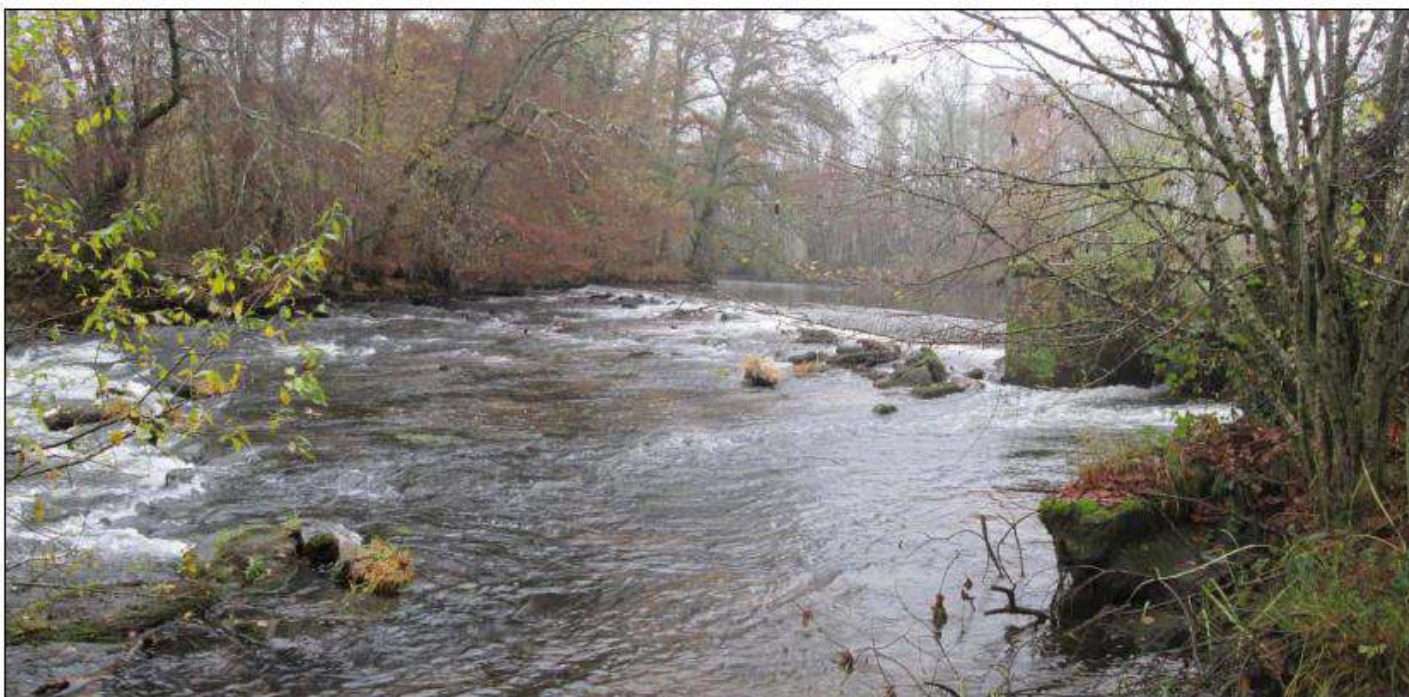
Photo n°2 : Vue aval du barrage prise en rive gauche
